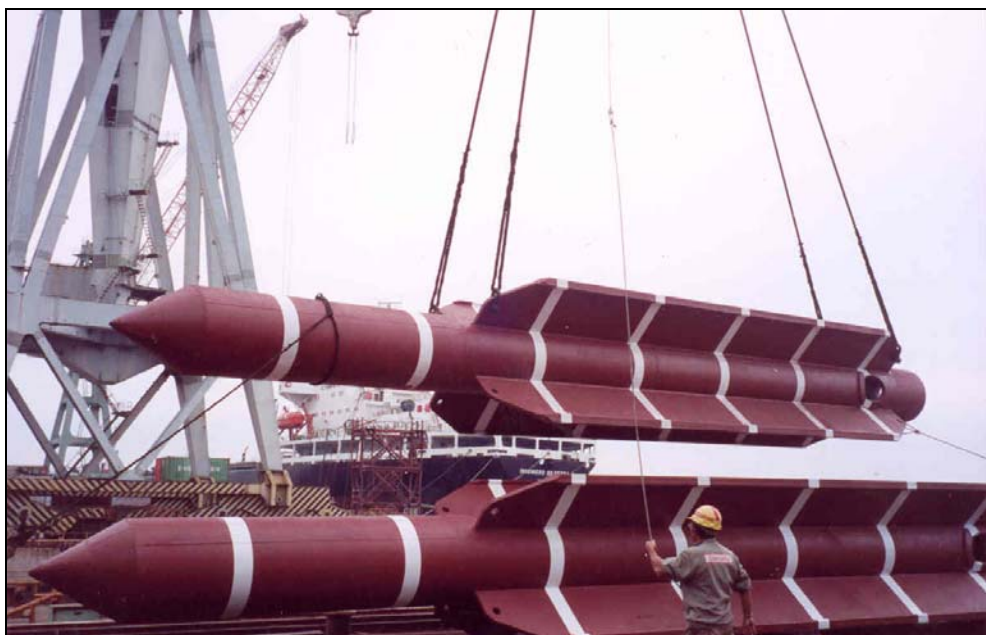
Figura 3.4.3-a. Estaca do tipo torpedo a ser utilizada na ancoragem do FPSO P-50
